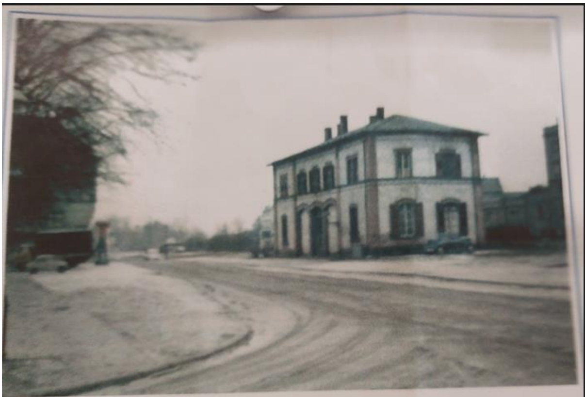
Ein winterliches Bild des alten Mühlburger Bahnhofs am Fliederplatz von 1968, der damals von dem unabhängigen Jugendclub „Werkstatt 68“ bezogen wurde. Dahinter sieht man noch einige Gebäude der Eisengießerei Seneca, die zwischenzeitlich abgerissen sind.
